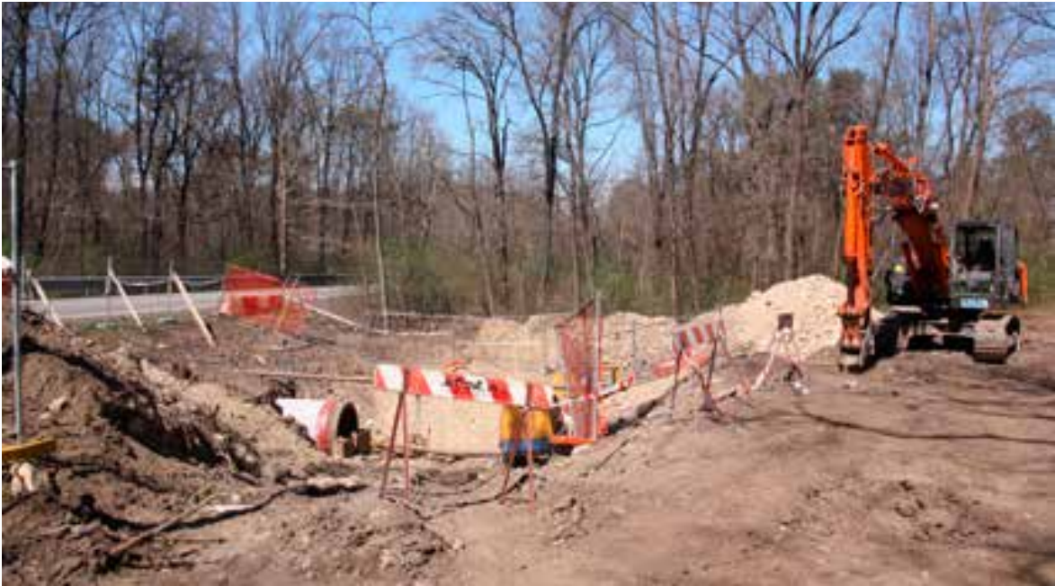
Il cantiere in fase operativa (foto Fabio Casale).
