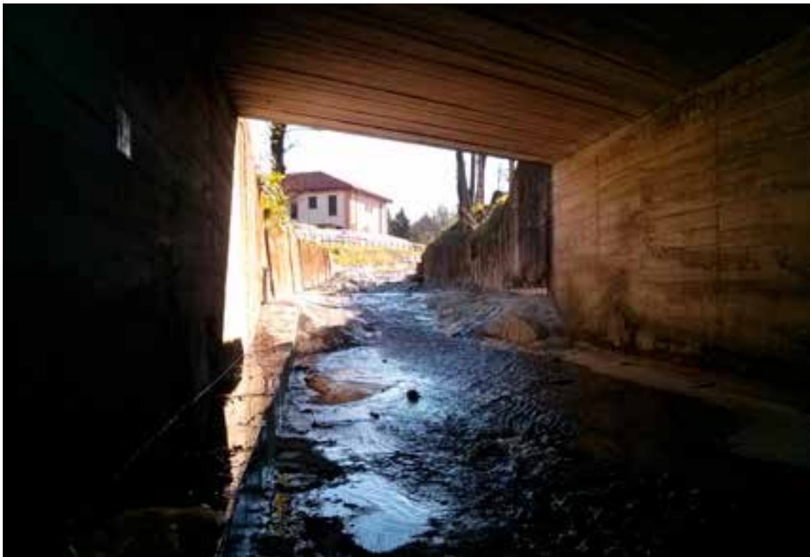
Il sito dopo gli interventi, con eliminazione della briglia al centro del corso d'acqua e completamento del passaggio in cemento lungo la sponda destra (foto Provincia di Varese).
