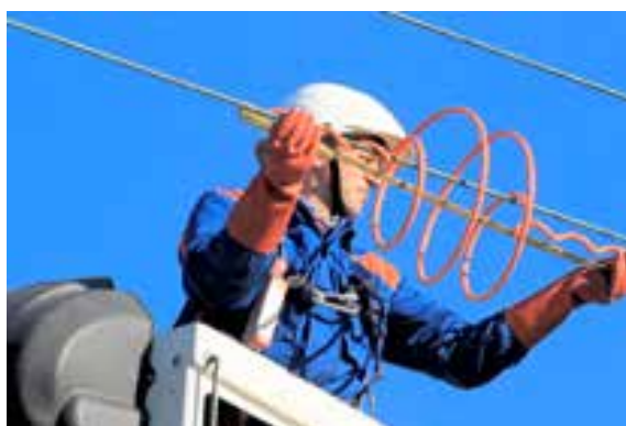
Operatore ENEL durante la posa di una spirale (foto Marco Tessaro).
