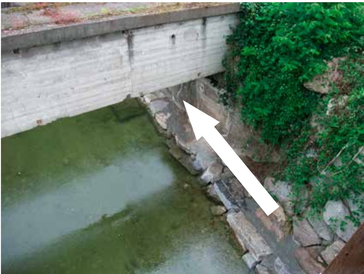
Passaggio completato, tramite posa di massi lungo la sponda destra del fiume Bardello, visto dall'alto (foto Provincia di Varese).
