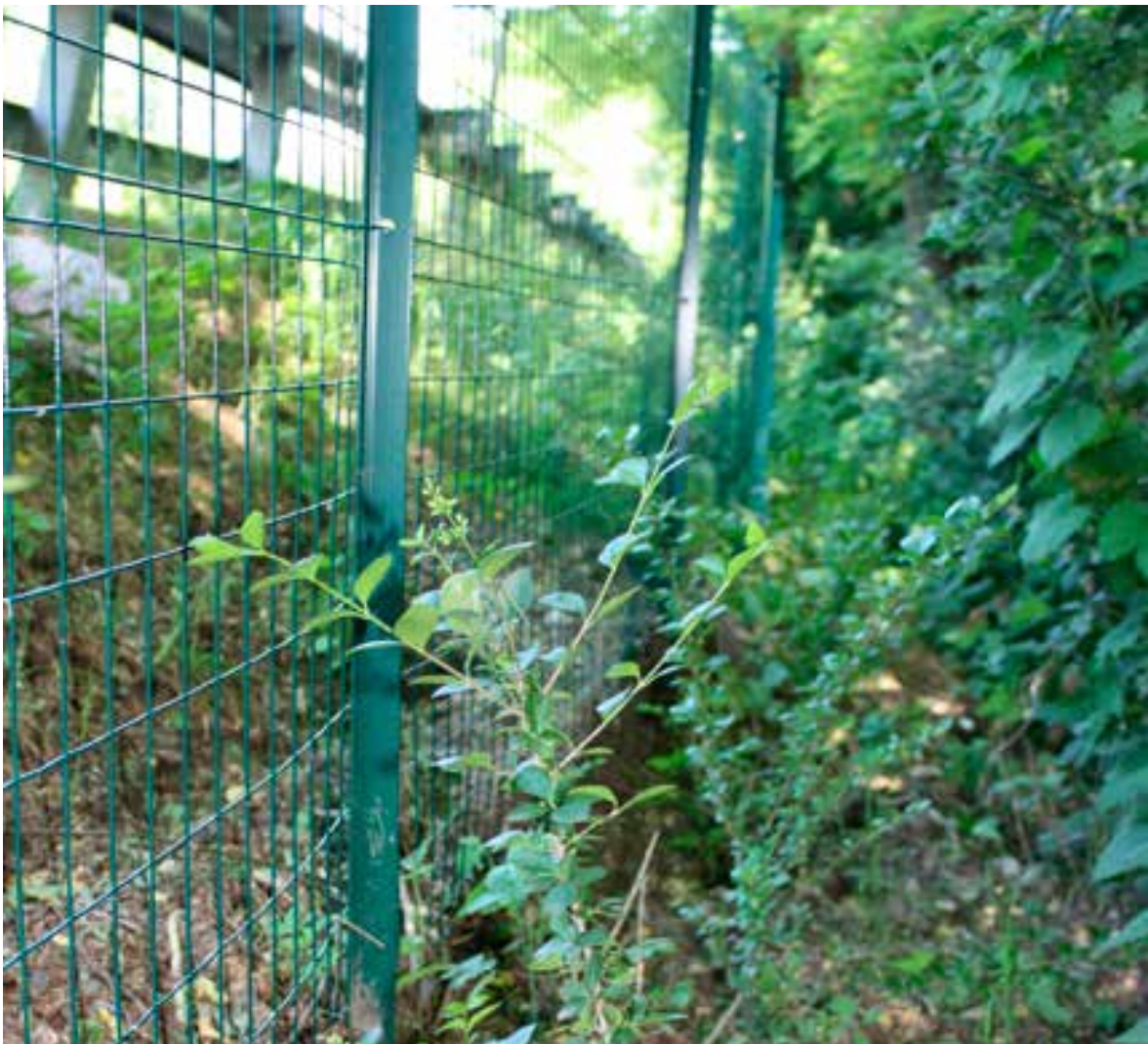
Lungo i due lati della SS 629 sono state posizionate reti metalliche e siepi, per dissuadere il passaggio della fauna (foto Fabio Casale).
