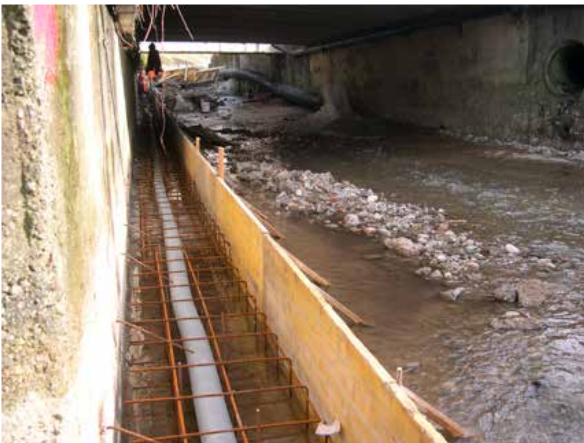
Realizzazione di passaggio in cemento lungo la sponda destra (foto Provincia di Varese).
