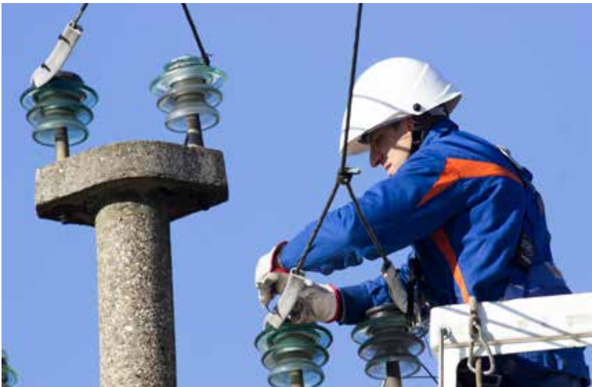
Operatore ENEL durante il posizionamento del profilo in gomma (foto Marco Tessaro).
