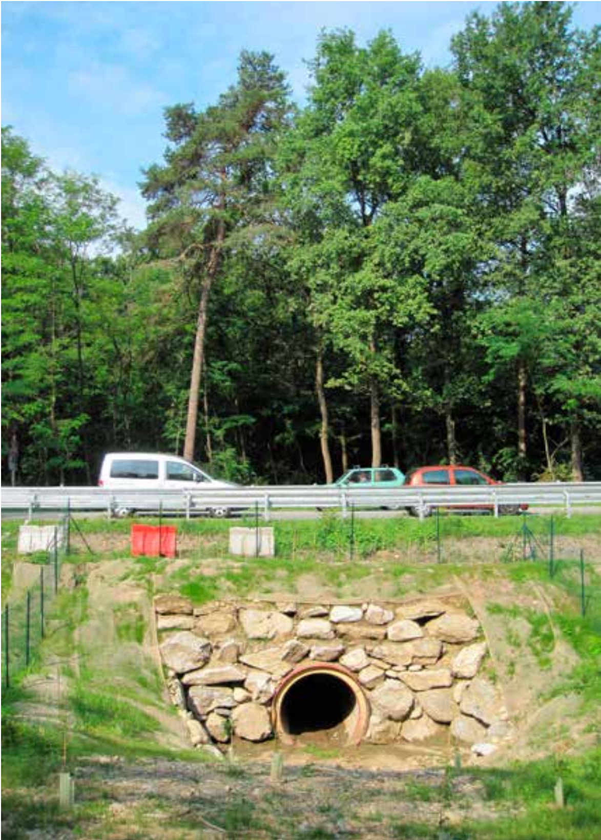
Veduta d'insieme dell'area di intervento al termine dei lavori. Si notino le rampe di raccordo inerbite, la recinzione metallica e la messa a dimora di essenze arboree autoctone (foto Massimo Soldarini).
