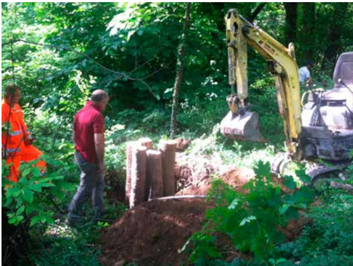
Realizzazione di una Log pyramid (foto Francesco Radrizzani).
