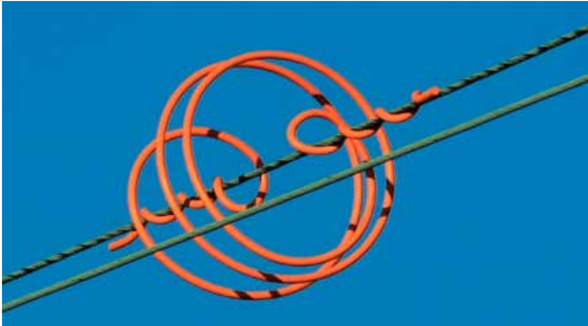
Spirale applicata lungo la linea elettrica di Mornago (foto Marco Tessaro).
