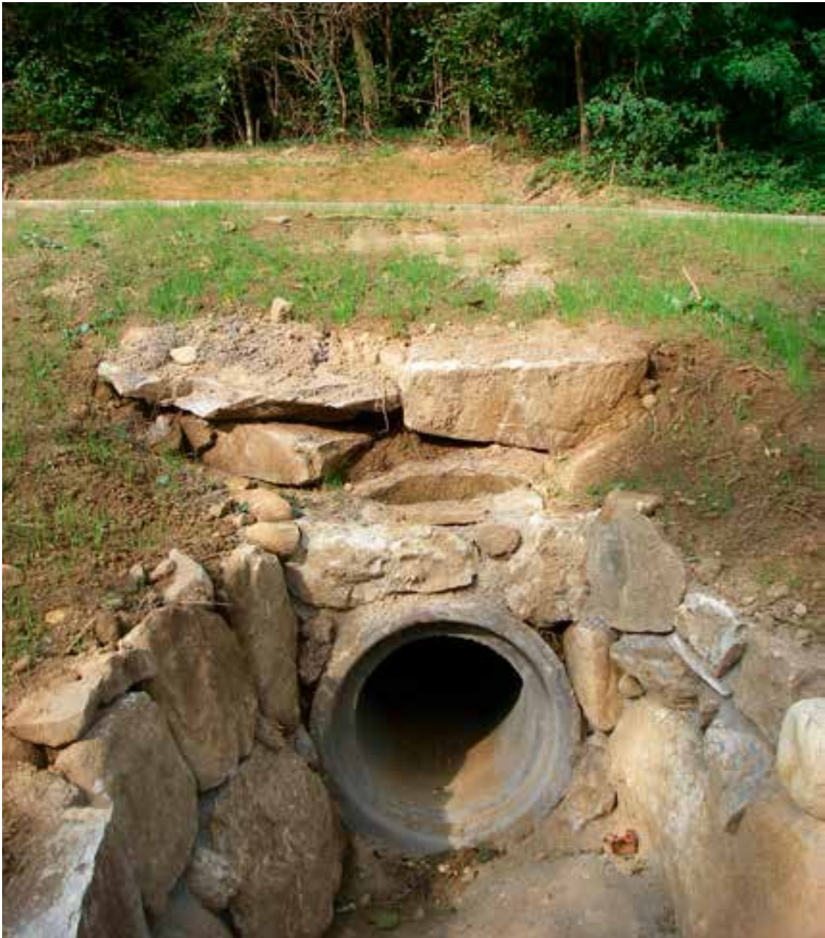
Particolare del punto di uscita verso valle del sottopasso (foto Provincia di Varese).
