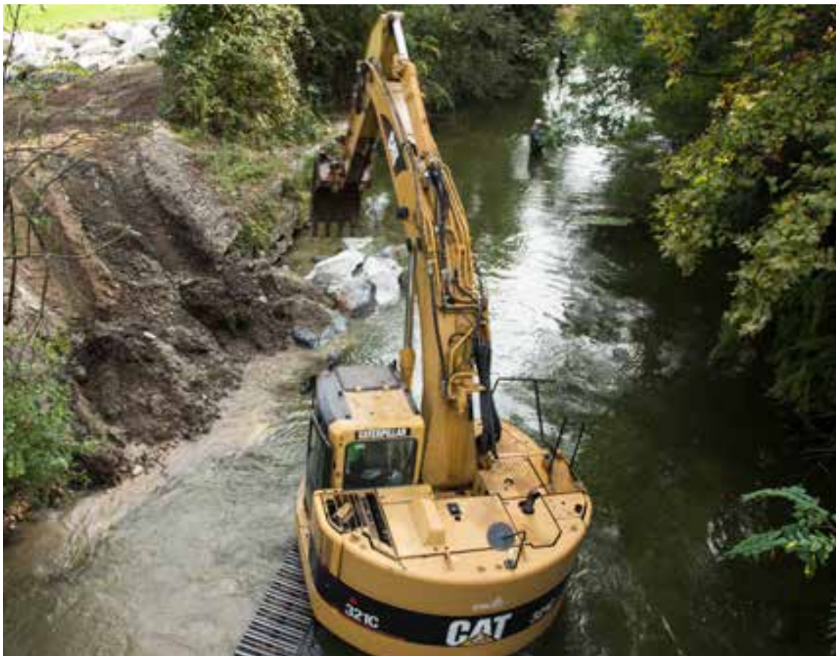
Posa di massi ciclopici, al fine di creare un passaggio con massi ammorsati lungo la sponda destra (foto Marco Tessaro).
