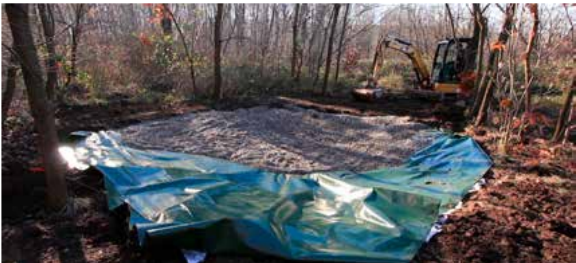
Posa di telo impermeabile e di ghiaietto nella pozza di Lentate Verbano (sud), in comune di Sesto Calende (foto Marco Tessaro).
