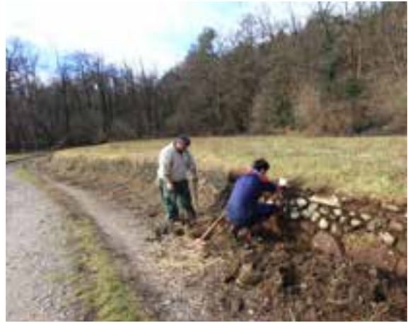
Intervento di ripristino di muretto a secco in comune di Casale Litta. A sinistra: l'area prima dell'intervento (foto Chiara Farioli/Idrogea servizi srl); a destra: fase di realizzazione del ripristino (foto Marco Tessaro).
