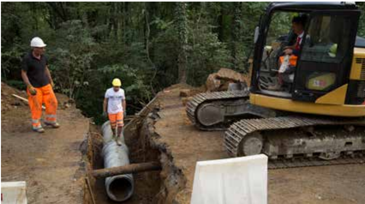
Posa del sottopasso (foto Marco Tessaro).
