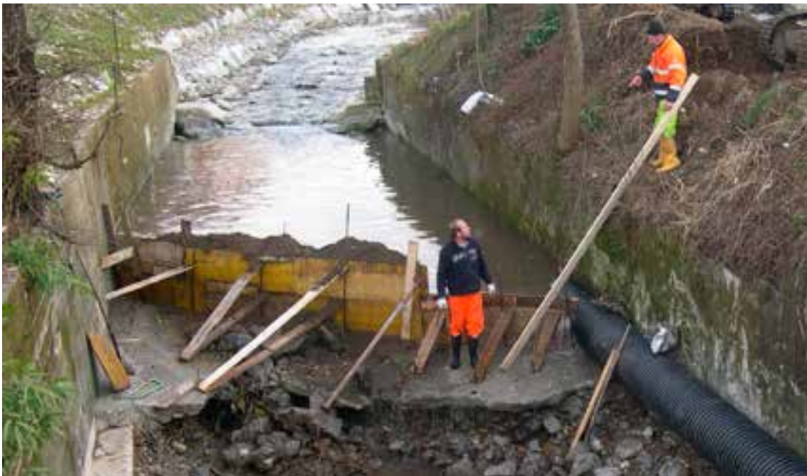
Convogliamento provvisorio del corso d'acqua per permettere l'esecuzione dei lavori (foto Provincia di Varese).
