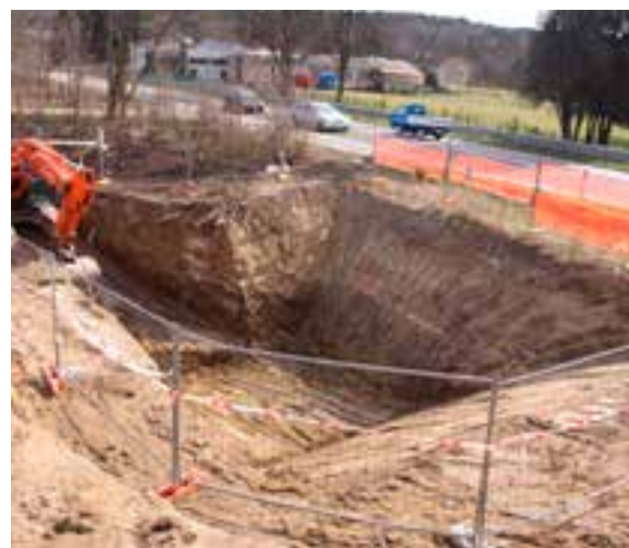
Scavo per realizzazione di sottopasso a Sesto Calende (foto Fabio Casale).
