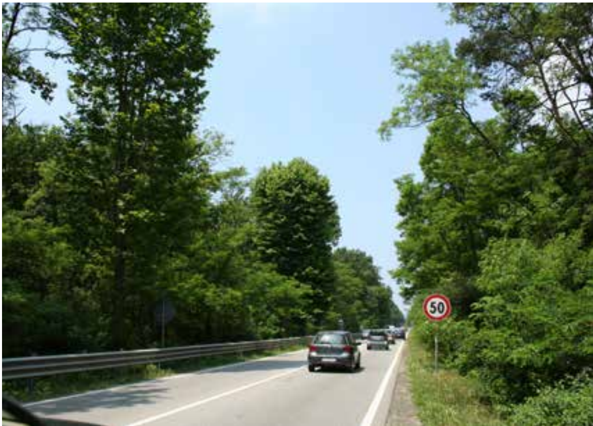
L’area dell’intervento (foto Fabio Casale).
