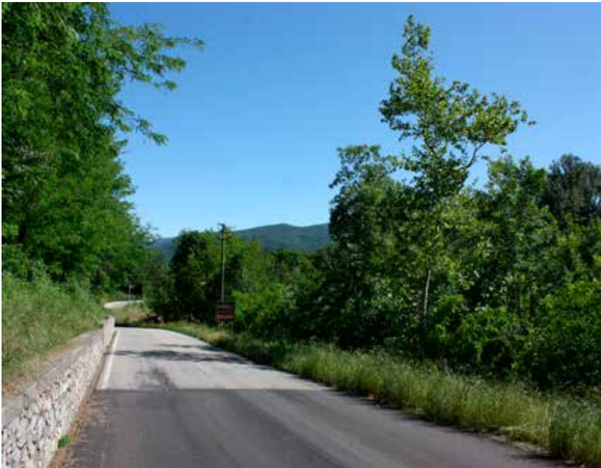
Area di intervento del sottopasso per Anfibi lungo la SP18 a Bregano. Si nota (più scuro) il tratto stradale interessato dalla riasfaltatura dopo la posa del sottopasso (foto Fabio Casale).
