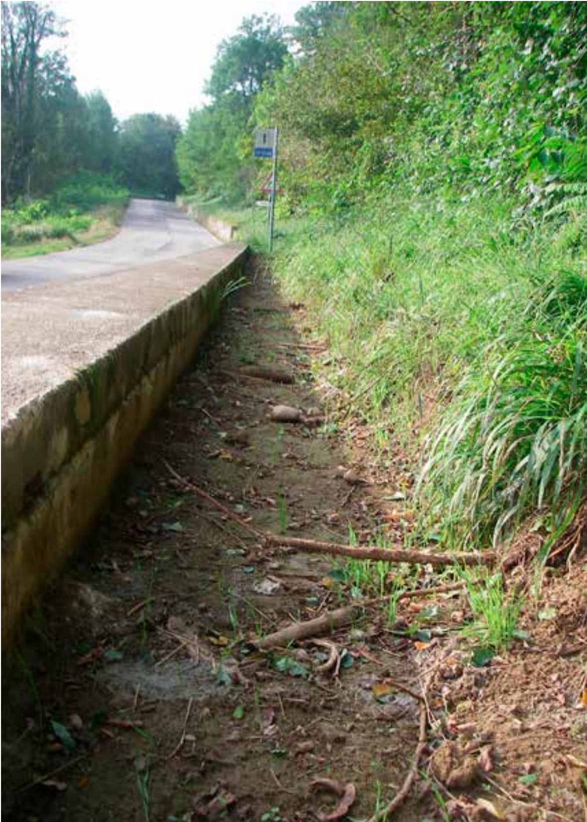
Particolare della zona a monte del sottopasso, con trincea e muretto di contenimento che fungono da “invito” per gli Anfibi all’utilizzo del sottopasso stesso (foto Provincia di Varese).
